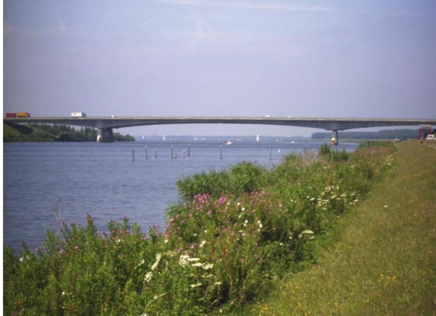
Een beweegbare kering bij de Stichtse Brug is één van de mogelijke oplossingen
